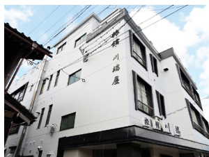
外壁塗装をした店舗外観
